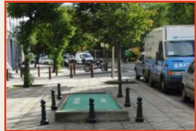
Trappe d'accès secours
